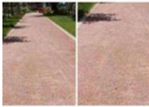
Χωμάτινο σταθεροποιημένο δάπεδο
